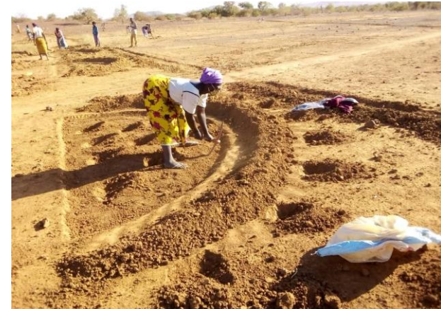
Réalisation d'une demi-lune
