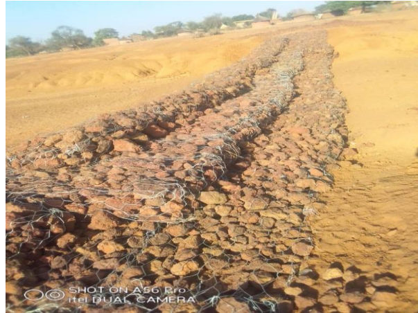
Traitement de ravine
